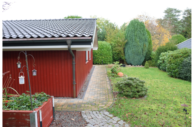
Neues Dach von 2024
